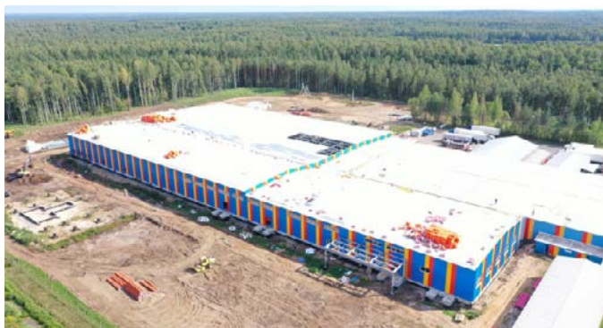
Расширение убойного цеха АО «Птицефабрика Северная»
