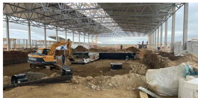
Строительство молочно-товарной фермы ООО «Племенной завод Бугры»
