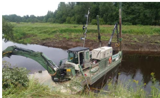
Процесс выполнения работ по расчистке р. Коваши
