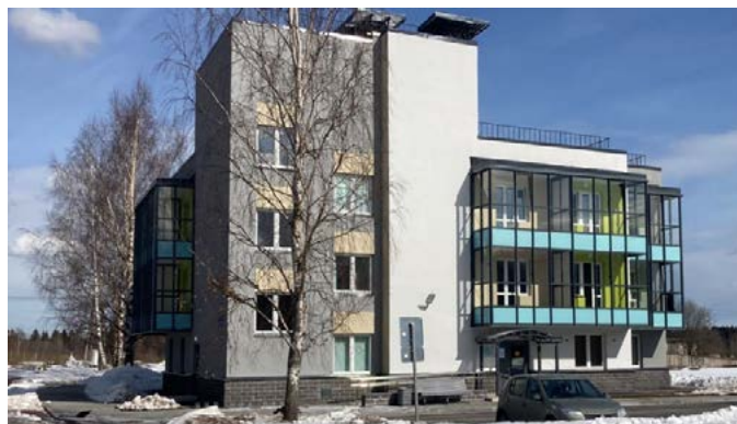
Дом сопровождаемого проживания во Всеволожском районе
